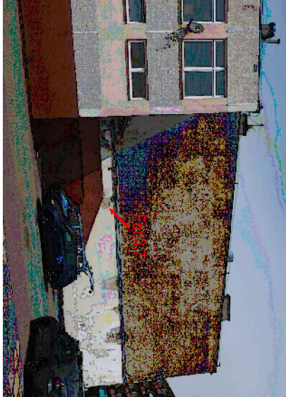
Fot.3.6 Ściana szczytowa budynku sali gimnastycznej nr1 Widoczne odspojenia i odparzenia tynku w miejscach
