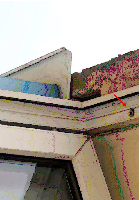
Fot. 2.5 Połączenie okien do filarków międzyokiennej ilości zbyt mała niezgodna z warunkami technicznymi.
