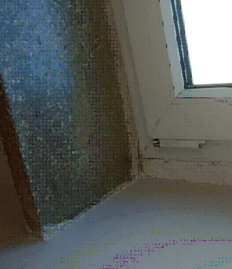
Fot. 1.8 Widok filarków międzyściennych od wewnątrz łącznika. Widoczne listwy drewniane poszerzające okna
